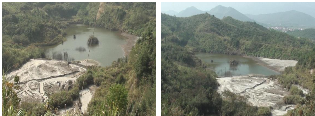
图 2-4-2 尾矿库及库坝
